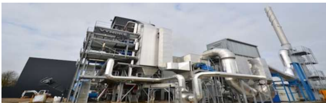
Centrale de Cogelan, à Lanvian en France
