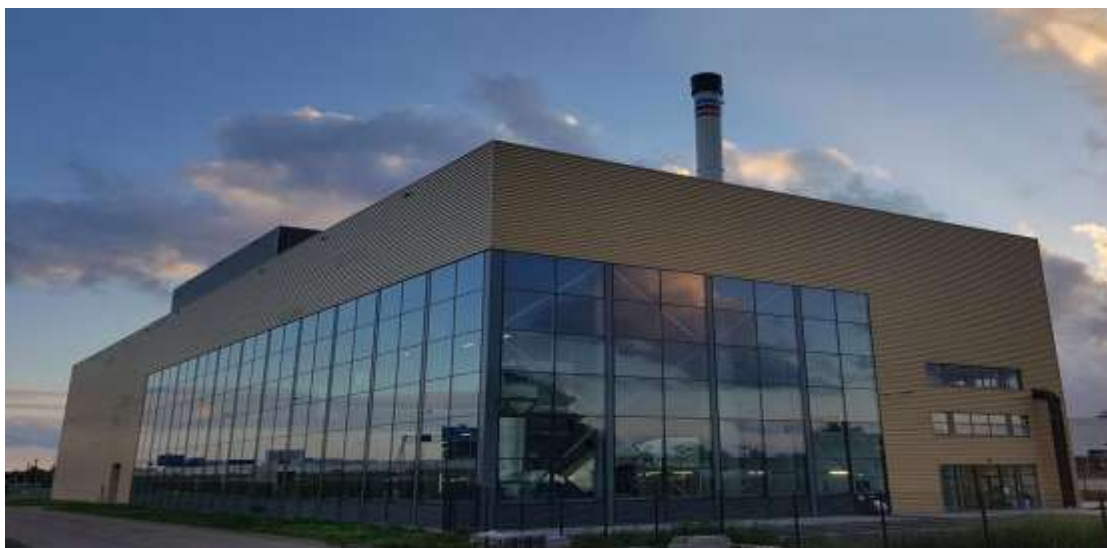
Centrale de bioénergie AEB, Amsterdam
